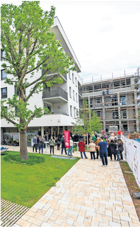
Einige Gebäude sind bereits bezogen, an anderen wird noch gebaut. Foto: Andreas Essig
